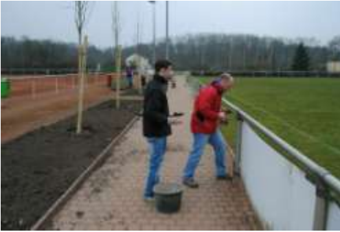
Auch lose Barrieren wurden befestigt
