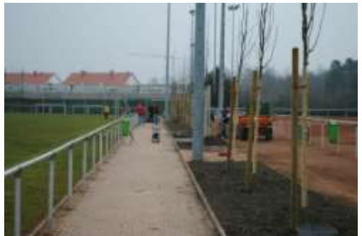
Vorbereitung für die Plasterung
