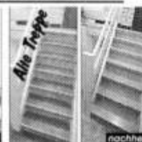
Treppen-Renovierung Stufe für Stufe neu
