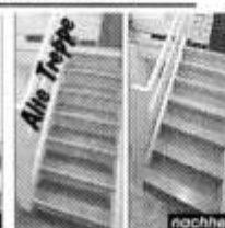
Treppen-Renovierung Stufe für Stufe neu
