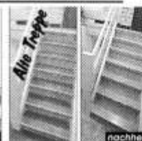
Treppen-Renovierung Stufe für Stufe neu
